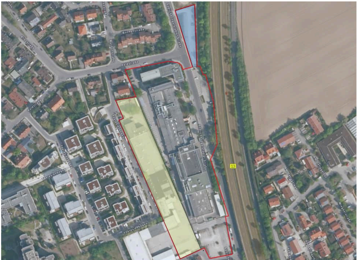
Abbildung 1: Planungsgebiet (rot umrandet), Gebiet in dem Gebäude abgerissen wurden (gelb hinterlegt) und der Parkplatz, der gepflastert wurde (blau hinterlegt), Luftbildquelle: BayernAtlas (abgerufen am 07.06.2022)
