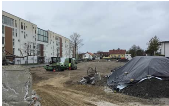
Blick von Abbruchfläche auf westlich angrenzende Häuser
