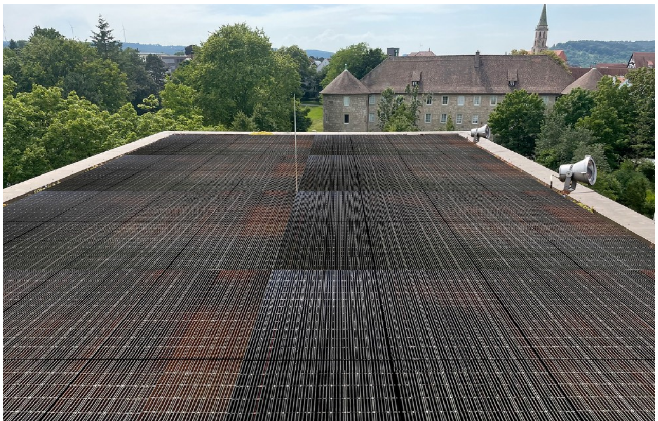
Flachdach mit PRPs belegt, kristallines Structural Glazing mit wetterfester homogener Glasoberfläche
