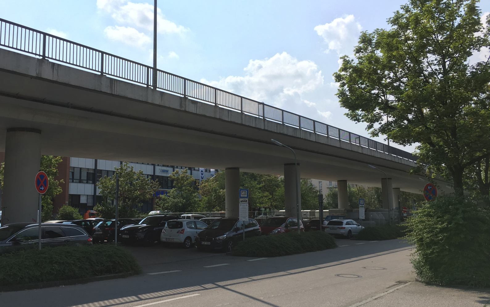
Abb. 10: oben: Le-Crès-Brücke Blickrichtung Valerystraße Abb. 11: unten: Robert-Schuman-Straße Blickrichtung Westen
