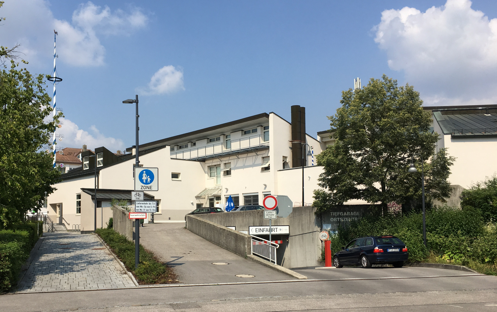
Abb. 12: oben: Zufahrt Tiefgarage Rathaus Abb. 13: unten: Zufahrt Tiefgarage IAZ
