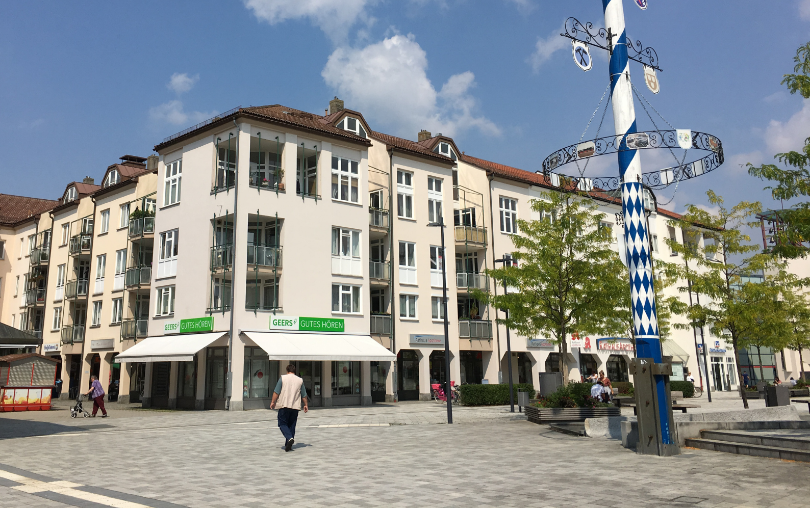
Abb. 8: oben: Ärztehaus Rathausplatz 2 & 3 Blickrichtung Nordost Abb. 9: unten: Bereich zwischen IAZ (links) und Ärztehaus (rechts) Blickrichtung Norden
