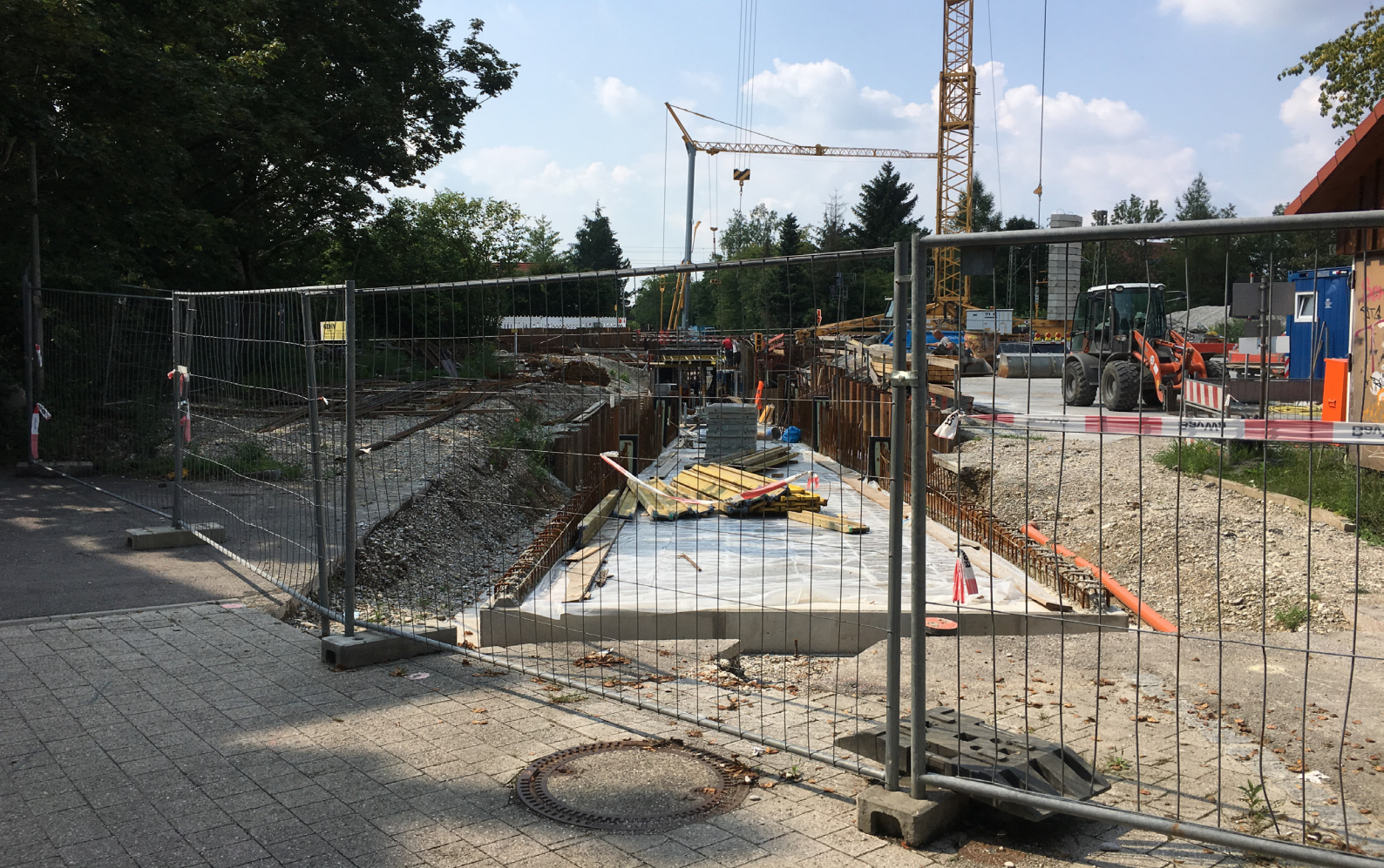
Abb. 14: oben: Baustelle Fußgängerunterführung Robert-Koch-Weg - Bergstraße Abb. 15: unten: Rückwärtige Anlieferbereich Hotel Blickrichtung Nordost
